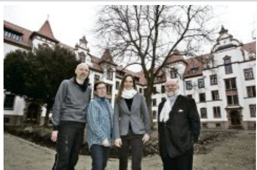
Zufrieden: Architekt Olaf Schröder (von links), Sibylle Maurer-Wohlitz vom BUND Region Hannover, Verena Michalek von Proklima und Stiftungsvorstand Reinhold Fahlbusch vor dem frisch sanierten Wohngebäude in der Calenberger Neustadt. Foto: Behrens
