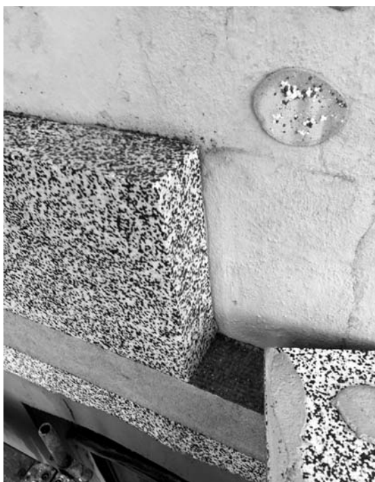
Eine nachträgliche Dämmung senkt die Heizkosten nachhaltig
