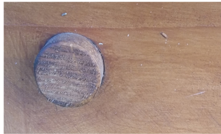
Holzbolzen Pumpenhaus am Teich
